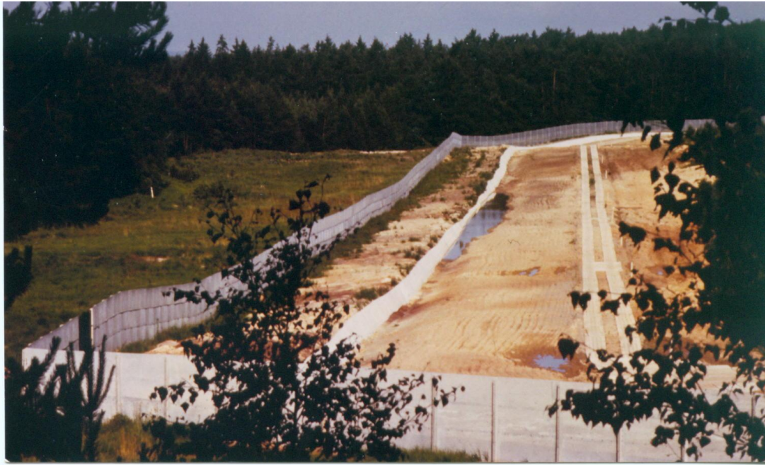
Die ab den siebziger Jahren von der DDR aufgebaute „Moderne Grenze“: Einreihiger, 3,20 m hoher Metallgitterzaun, Kfz.-Sperrgraben, Kontrollstreifen und Fahrweg.
